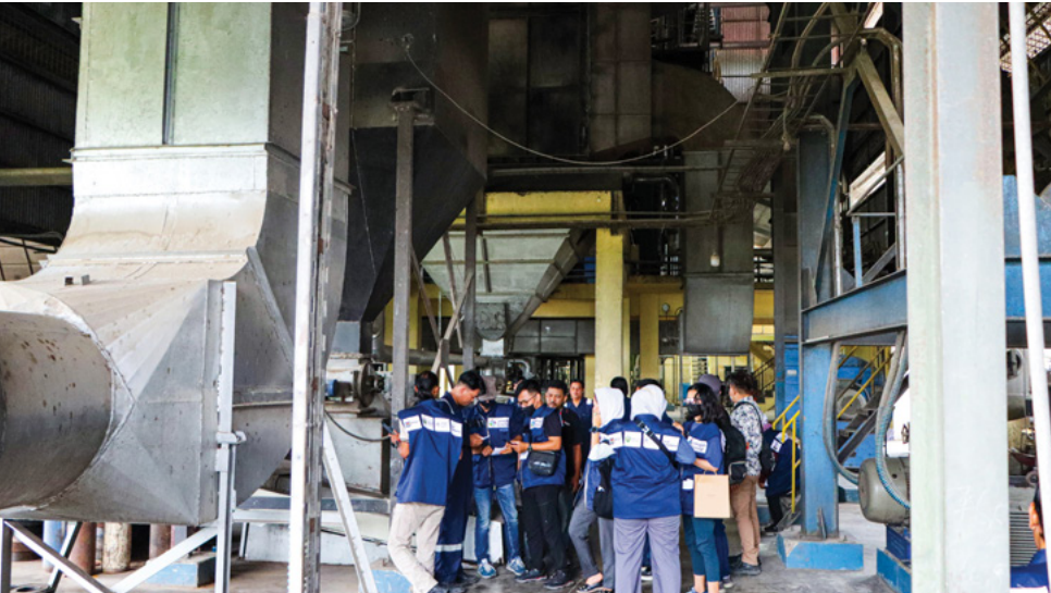
▲ Kunjungan peserta Jelajah Energi Sumatera Selatan di pabrik PT Buyung Putra Energi
