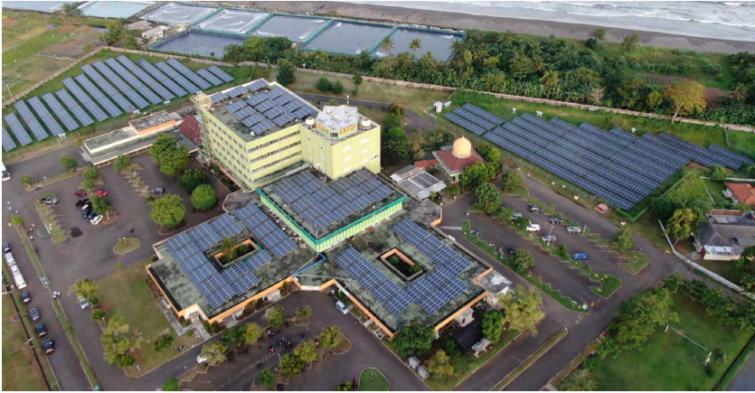
Instalasi panel surya di Pembangkit Listrik Tenaga Surya (PLTS) Pertamina Refinery Unit IV Cilacap di area Rumah Sakit Pertamina Cilacap (RSPC) di Cilacap, Jawa Tengah.
