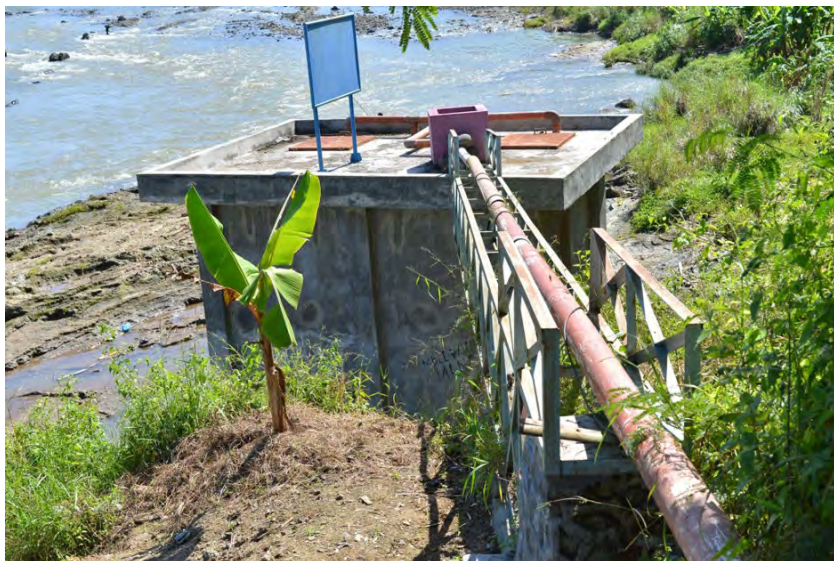
Bangunan pompa air di dekat Sungai Tajum, Desa Kaliurip, Kec. Purwojati, Kab. Banyumas, Jawa Tengah.
