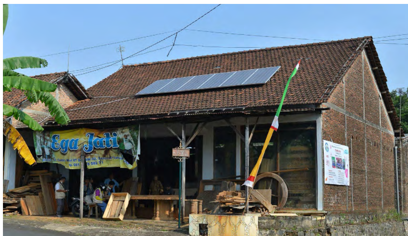
Pengrajin seni ukir relief kayu Jepara memanfaatkan Pembangkit Listrik Tenaga Surya (PLTS) atap dari Pemerintah Provinsi Jawa Tengah.
