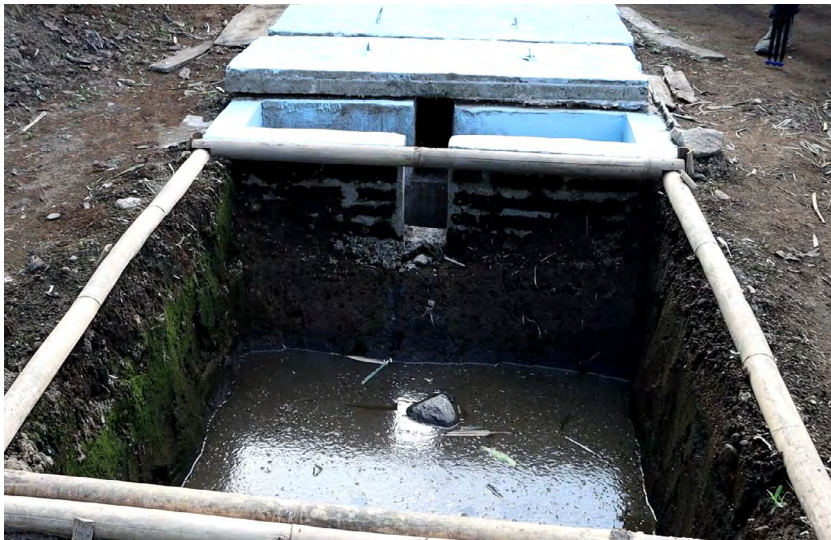
Digester penampungan limbah kotoran sapi yang sudah diencerkan dengan air (1:1), selanjutnya diolah dan dimanfaatkan untuk biogas.
