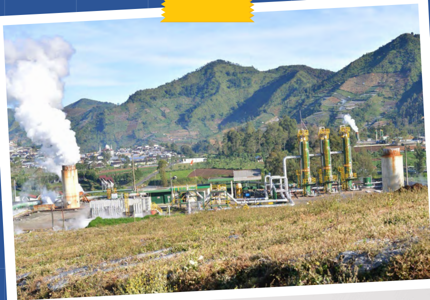
PLTP PT Geo Dipa Energi, Dieng. (Dokumentasi : IESR)
