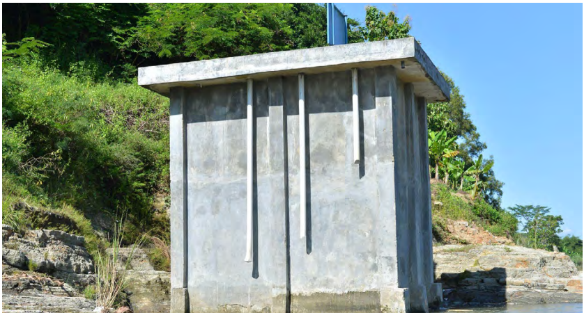
Instalasi pompa air tahan banjir tenaga surya di Desa Kaliurip, Kecamatan Purwojati, Kabupaten Banyumas, Jawa Tengah.
