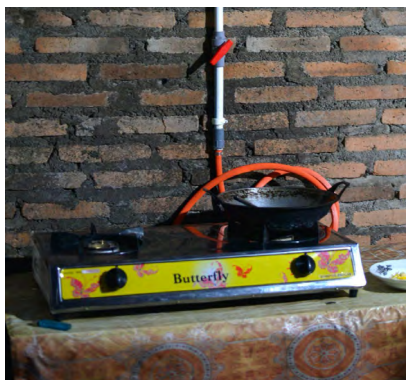
Pemanfaatan Biogas dari Limbah Kotoran Sapi untuk Kebutuhan Memasak Warga di Desa Samirono, Kecamatan Getasan, Kabupaten Semarang, Jawa Tengah.
