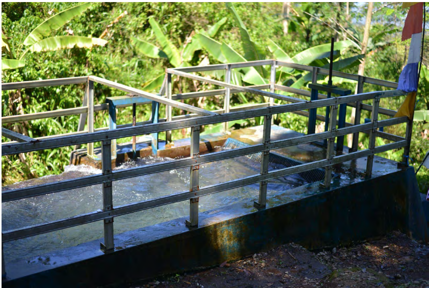
Penyaring berupa jeruji beton agar aliran air tak terhambat oleh sampah di PLTMH Desa Karangtengah.
